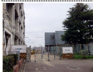
▲ 正門東側にはフェンス
