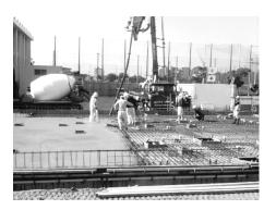
運動場の校舎建設の基礎工事が終盤を迎えました。見えている基礎の下には2m以上の鉄筋とコンクリート、断熱材が何層にも入っています。建物も人も同じところは、一見見えないところに**ゆるぎない基礎があってこそ**、安心できるというところですね。
